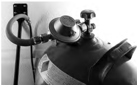
Anschluss des Gasreglers an der Gasflasche
