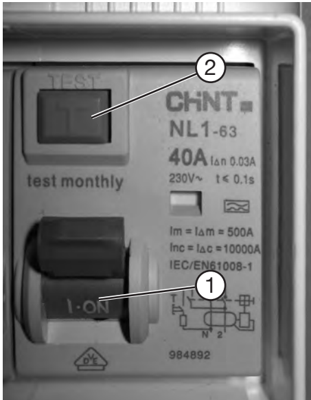
FI-Schutzschalter und Testknopf
