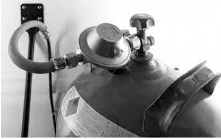
Anschluss des Gasreglers an die Gasflasche
